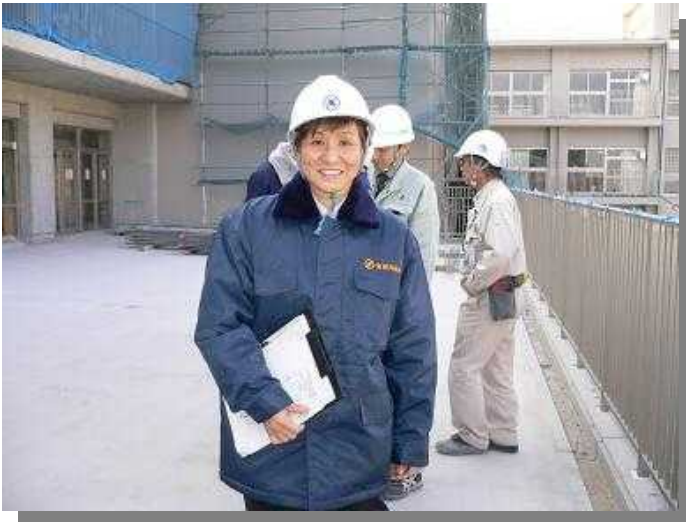
2/7 長尾小学校改築工事監査
